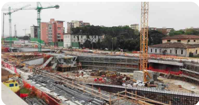
Sopra, lo scavo per la realizzazione del passante dell'alta velocità e, a fianco, come sarà la nuova stazione di Firenze Belfiore
